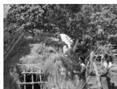
写真8・9 周囲の足場を固め、かやを束ねて葺く
