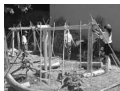
写真6・7 柱を立て、屋根・家の枠組みを作る
