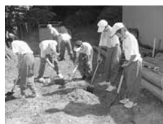
写真5 地面を掘り下げ地盤作り
