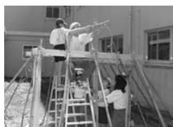
写真6・7 柱を立て、屋根・家の枠組みを作る
