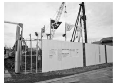
写真1 施設の工事現場
